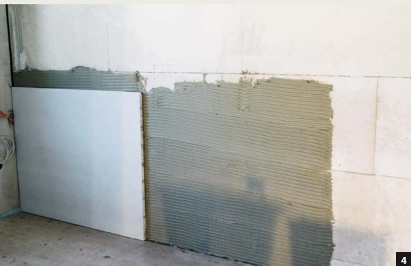
**Abb. 4:** Nach der Vorbereitung des Untergrunds und dem gleichmäßigen Kleberauftrag wird die Dämmplatte fest in das vollflächige Kleberbett eingedrückt.
