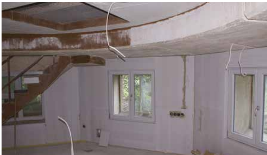
Verarbeitung der Klimaplatte im Turm
